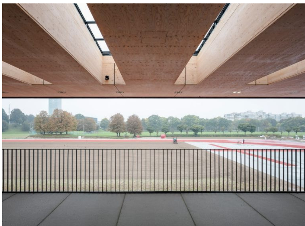
Das Tragsystem der nicht alltäglichen Konstruktion besteht aus 40 Hohlkastenelementen und überdacht auf einer Länge von rund 150 m großzügig die 100-Meter-Laufbahn und Außenterrasse. © Aldo Amoretti
