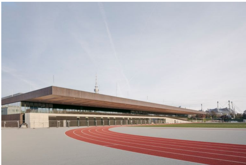
Architektonisch herausragend und prägend: Das stattliche, auf Pendelstützen gelagerte Vordach-Süd in Holzbauweise, der größte Hingucker des Projekts. © Aldo Amoretti
