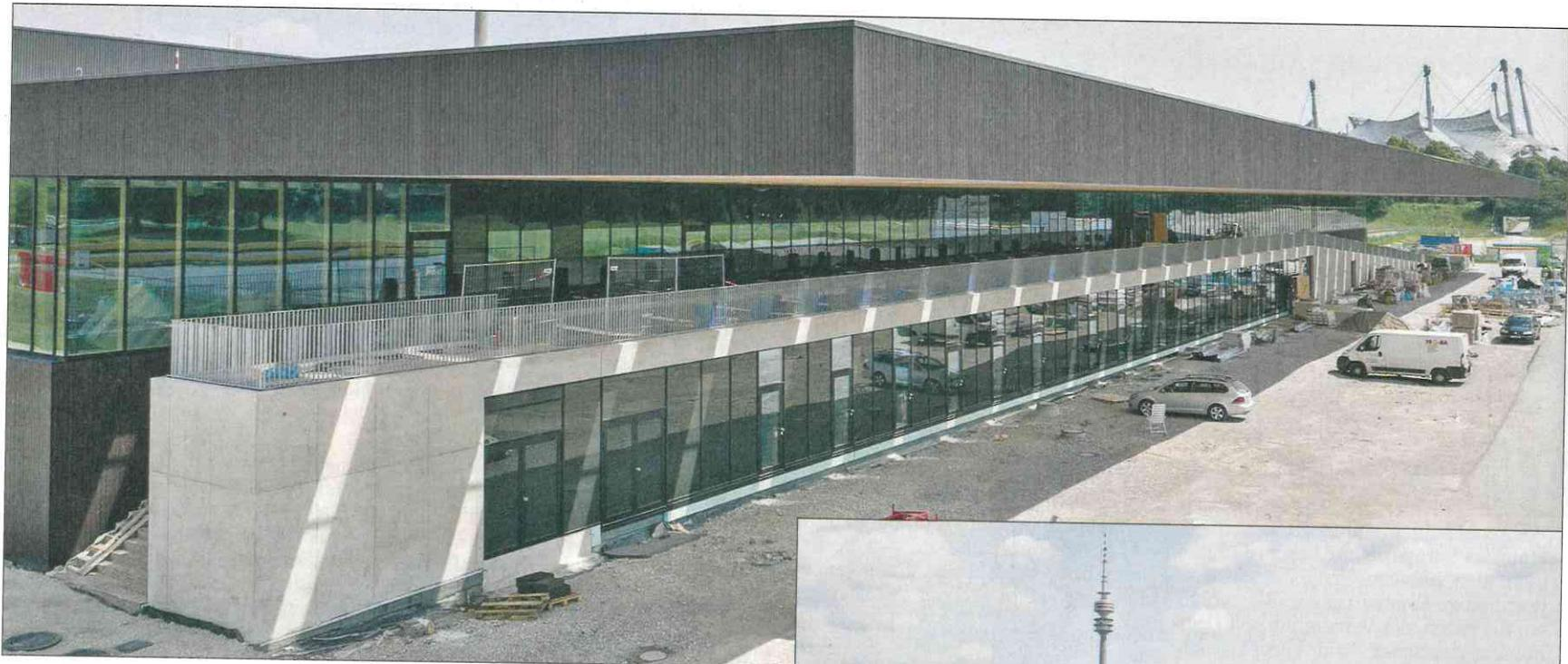
Prägend für die Bauaufgabe war das weit ausragende Vordach aus 40 Hohlkasten-Elementen. Die knapp 28 m langen und 1,60 m hohen Dachelemente haben eine freie Auskragung von 18,60 m und schützen später die 100-Meter-Laufbahn vor der Terrasse bzw. Rampe auf einer Länge von 150 m. Fotos: Aldo Amoretti (2)
