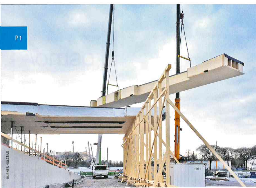
◀ Ein Lehrgerüst am Ende der Auskragung stützt die Vordach-Elemente während der Montage
