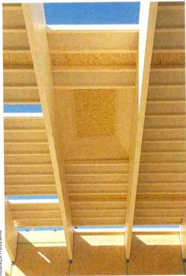
◀ Montage der Binder für die Sporthallen Süd mit Akustikplatten-Untersicht und abgedecktem Oberlichtkranz
